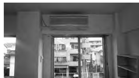
暖房ラジエーターを撤去し空調機を設置
